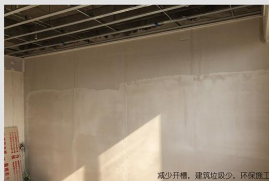
减少开槽，建筑垃圾少，环保施工
